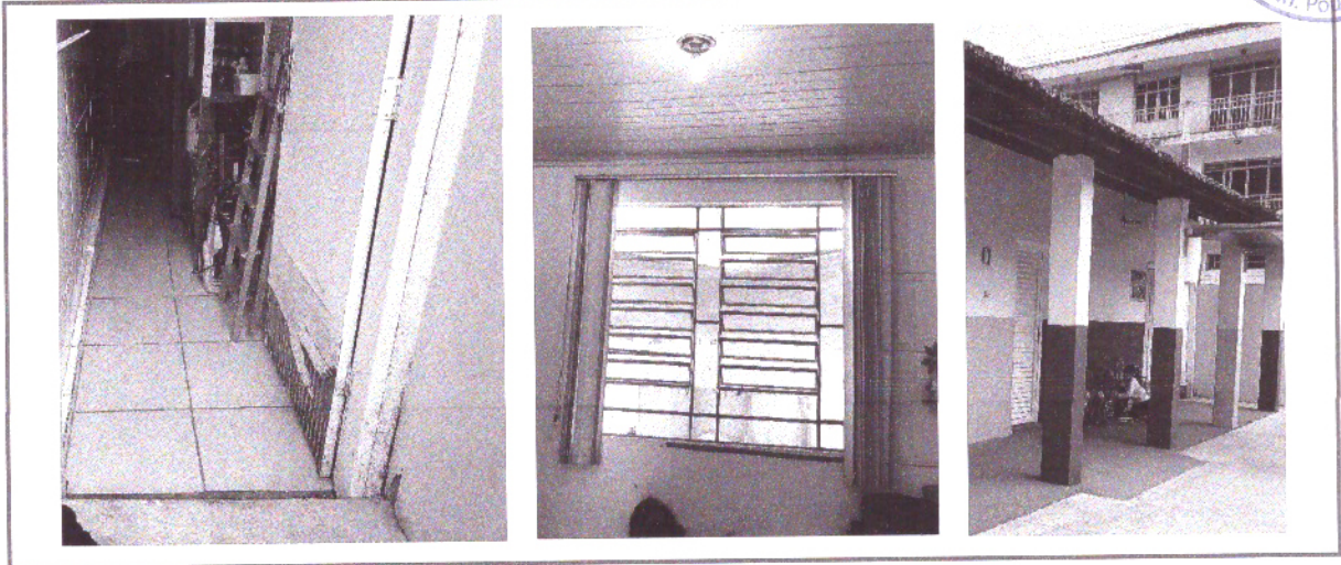
Figura 3 – Esquadrias do bloco a ser demolido.
